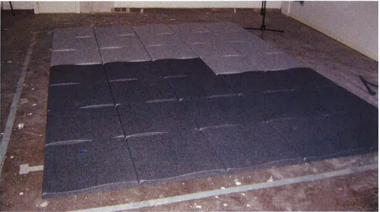
Wall paneelit asennettuna kaiuntahuoneen lattialle.
